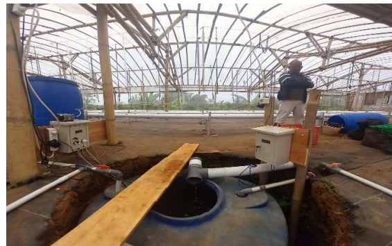
Gambar 14. Pemasangan 2 control panel di greenhouse
