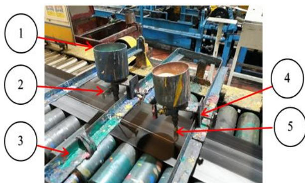
Gambar 1. Kondisi alat marking yang digunakan (sumber: PT.X)
