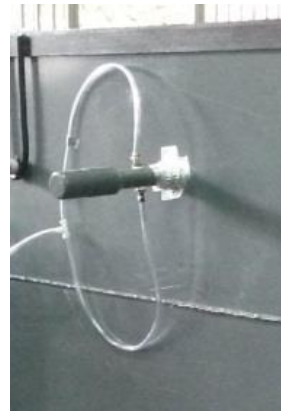
Gambar 9. Instalasi selang masuk CO 2 pada MAS
