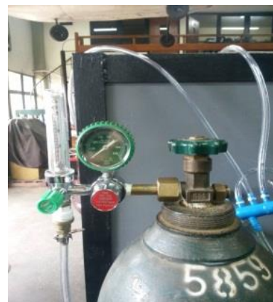
Gambar 12. Proses pemasangan regulator
