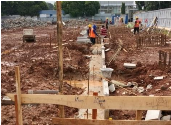
Gambar 10. Pemasangan Lantai Kerja
