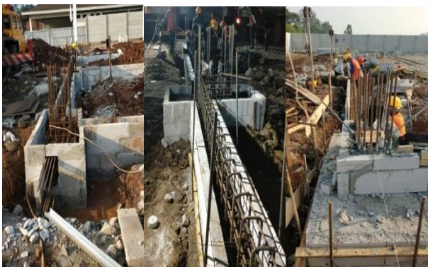
Gambar 14. Pemasangan Bekisting
