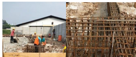
Gambar 13. Memosisikan dan Mengikat Baja Tulangan
