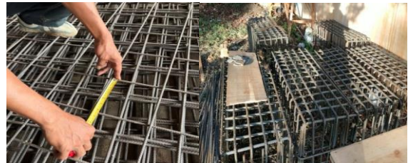
Gambar 12. Pengukuran Jarak Tulangan
