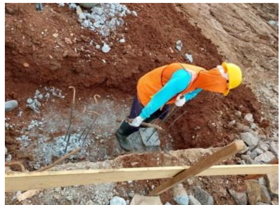
Gambar 9. Pemotongan Kepala Tiang Pancang
