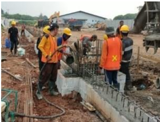
Gambar 17. Proses Pengecoran dengan Vibrator
