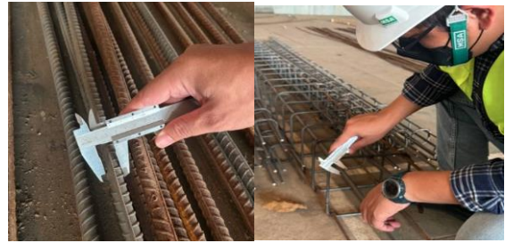
Gambar 11. Pengukuran Diameter Baja Tulangan
