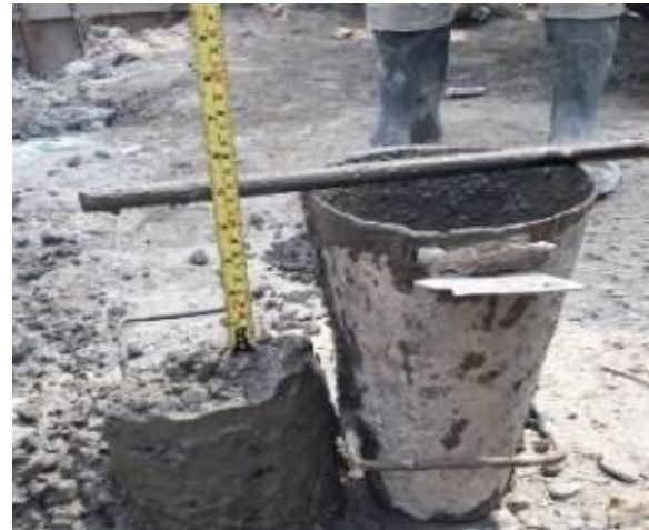
Gambar 15. Pengujian Slump Test Beton
