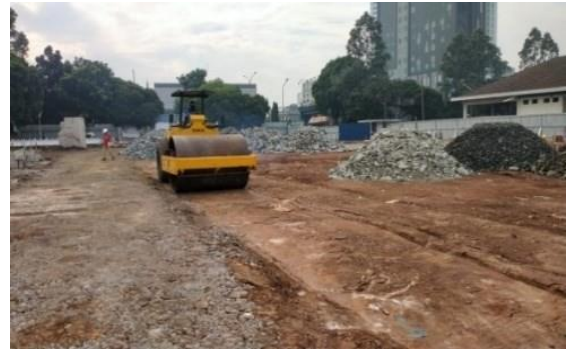
Gambar 8. Proses Pemadatan
