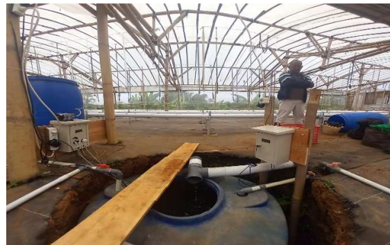
Gambar 14. Pemasangan 2 control panel di greenhouse
