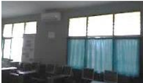
Gambar 4. Ventilasi udara ruang Lab. Komputer
